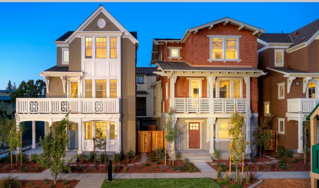
Projet : The Classics at Mirramonte Emplacement : Mountain View, CA Architecte: Classic Communities Constructeur : SBI Builders Produit : 7-1/8 po à enlignement de pattes égal Couleur : (de gau à dr) 2 couches Taupe, Redwood et Banyon Brown
