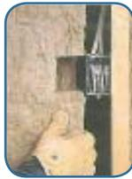
Mesurez la boîte et la hauteur à laquelle elle est fixée sur le montant d'ossature. Découpez la section de l'isolant qui correspond à cette hauteur. Glissez le matelas isolant derrière la boîte et poussez pour l'ajuster sur les côtés.
