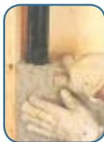
Pour les gros tuyaux d'évacuation, faites deux incisions à 45° en formant un sillon en V. Puis, glissez l'isolant autour du tuyau. Pour les petits tuyaux, procédez de la même manière que pour les fils ou câblages électriques.
