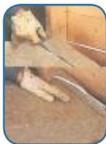
Faites une incision dans le matelas à la hauteur du fil ou du câble. Coupez le morceau à la moitié de l'épaisseur et rabattez-le en arrière pour insérer le fil ou le câble dans l'ouverture. Ramenez le matelas en place.
