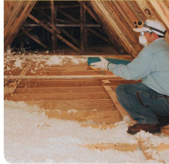
InsulSafe XC est un isolant supérieur de fibre de verre en vrac vierge non lié, blanc, qui est conçu pour application pneumatique dans des zones ouvertes et traitées, afin de minimiser la poussière et l'électricité statique lors de l'application.
