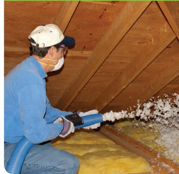
TrueComfort est un isolant supérieur de fibre de verre en vrac vierge non lié, blanc, qui est conçu pour application pneumatique dans des greniers ouverts et pour la modernisation des parois latérales fermées et des ensembles de construction de plancher/plafond à l'aide de l'appareil TrueComfort.
