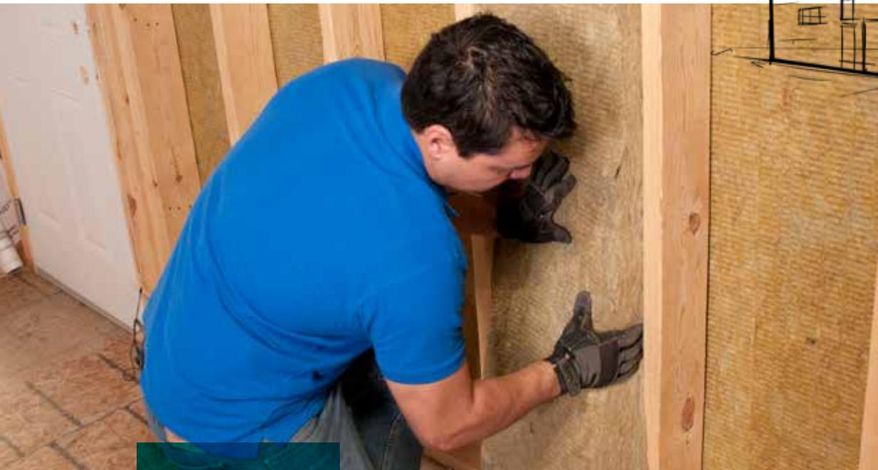
ROCKWOOL COMFORTBATT<sup>MC</sup> est un panneau isolant semi-rigide en laine de roche, conçu pour une utilisation extérieure, dans les immeubles neufs et les rénovations de bâtiments à charpente en bois et en acier.
