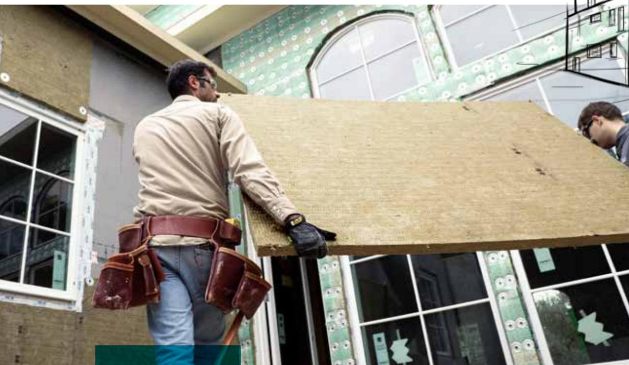
ROCKWOOL COMFORTBOARD<sup>MC</sup> 80 est un panneau d'isolation continue, rigide en laine de roche, utilisé pour le gainage non structural en construction résidentielle.
